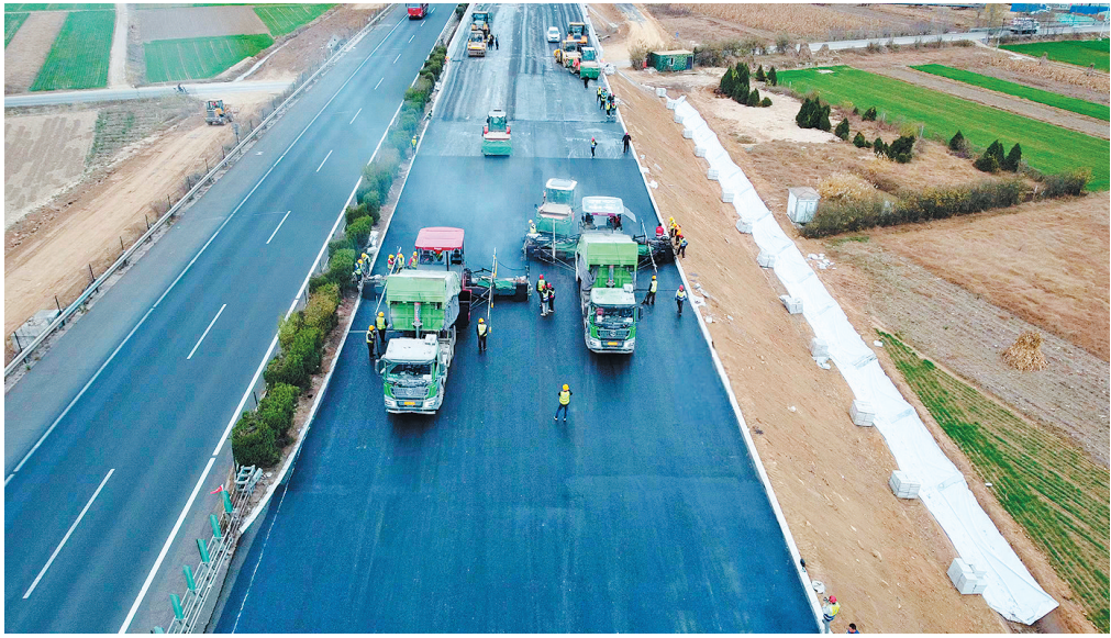
■沈海高速改扩建工程沥青摊铺施工现场。
