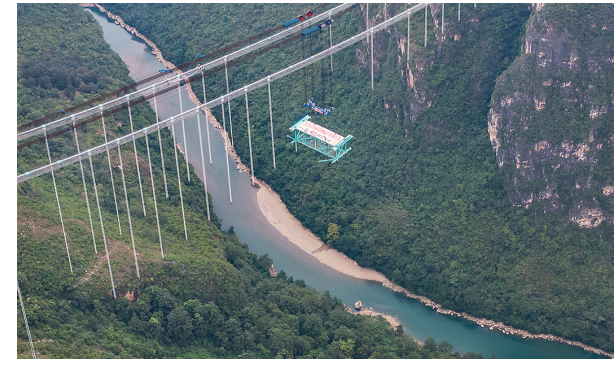
■花江峡谷大桥的首件钢桁梁吊装抵达指定位置（11月4日摄，无人机照片）。 新华社照片
