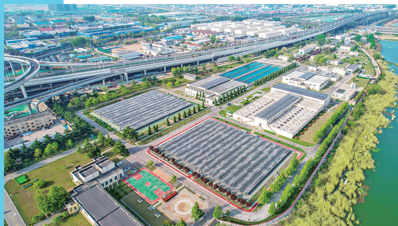
■青岛水务海润自来水集团仙家寨水厂。
