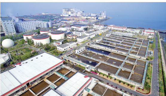
■青岛水务集团环境公司海泊河污水处理厂。
