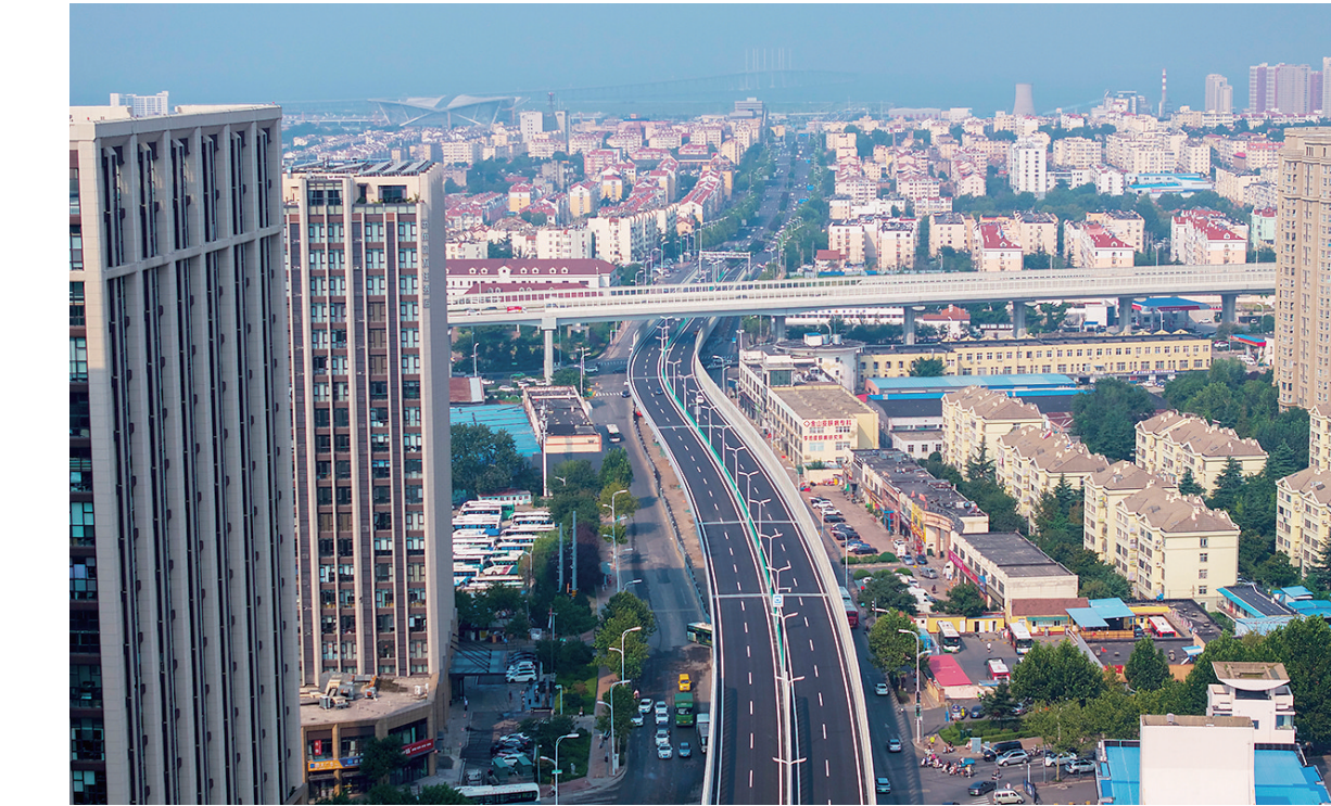
■重庆高架路金水路跨线桥通车。
