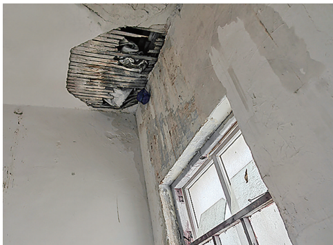
■河南路12号楼楼梯间顶部破损、漏雨。
