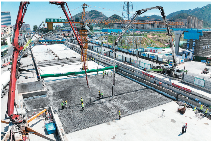
■唐山路快速路工程黑龙江中路地道闭口段主体结构最后一块顶板混凝土顺利浇筑完成。
