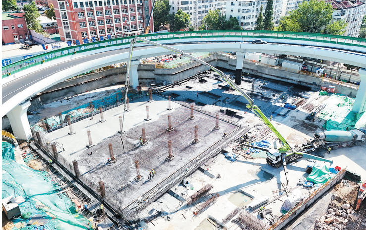
■山东路-鞍山路东北象限地下停车场项目顺利完成首块底板浇筑,正式进入主体结构施工阶段。
