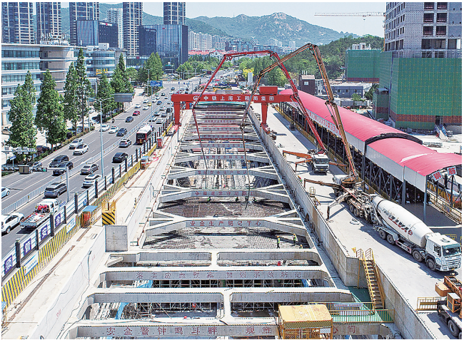
■在地铁5号线云岭路站，大型机械正在对主体结构顶板浇筑施工。
