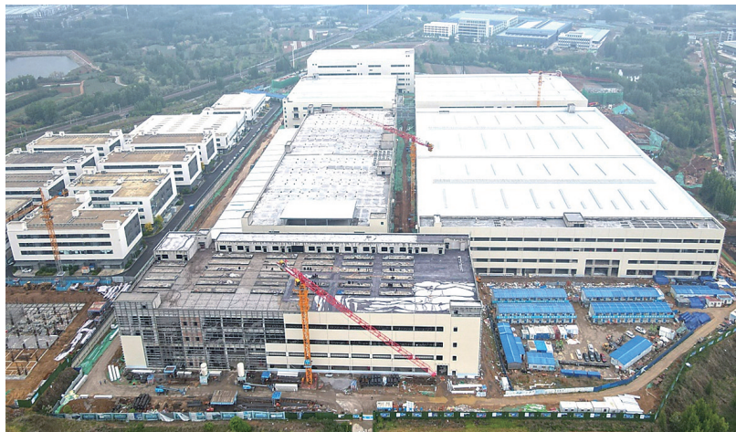
■建设中的水生态互联工厂项目。
