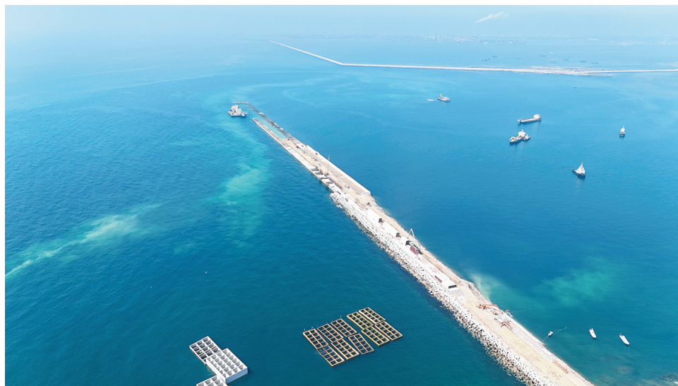
国家骨干冷链物流基地防波堤工程进入水上施工作业阶段。
