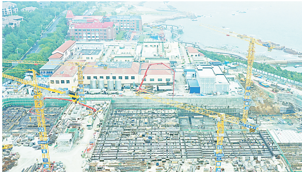
麦岛污水处理厂品质提升工程施工现场。
