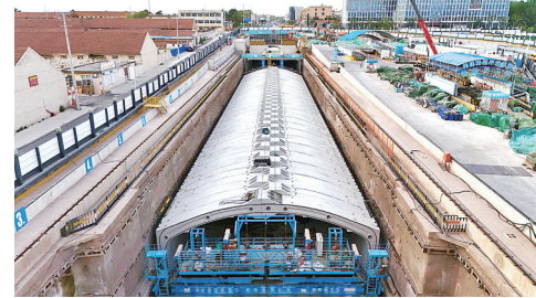
地铁7号线北安装配式主体结构顺利封顶。
