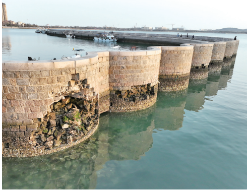
■唐岛湾东岸码头的防洪堤破损。
