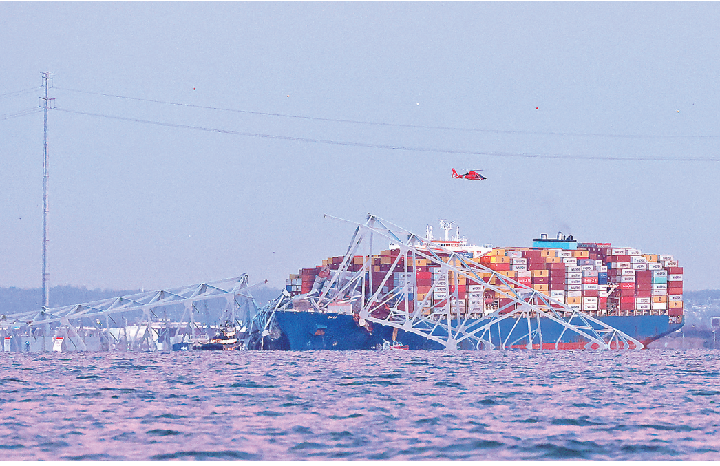
■这是3月26日在美国巴尔的摩拍摄的遭撞击后坍塌的“弗朗西斯·斯科特·基”大桥和撞击大桥的集装箱船。 新华社照片
