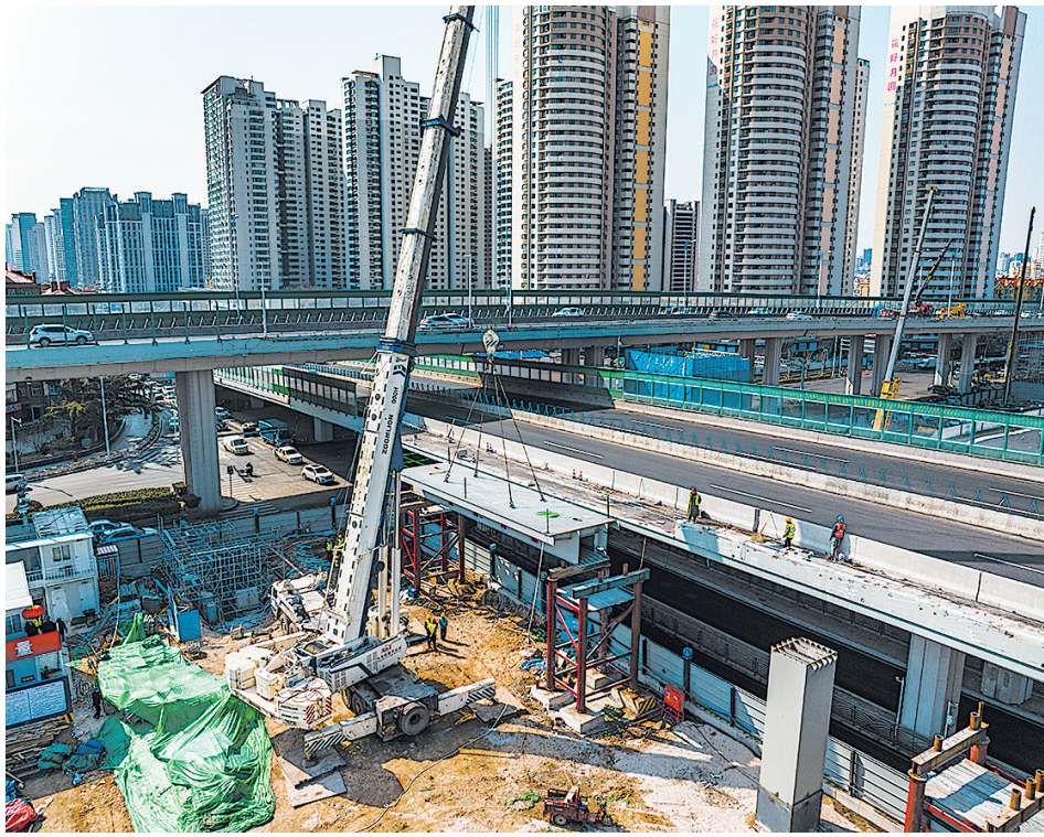
■山东路-鞍山路东北象限连接匝道及地下停车场工程完成首跨钢箱梁架设。
