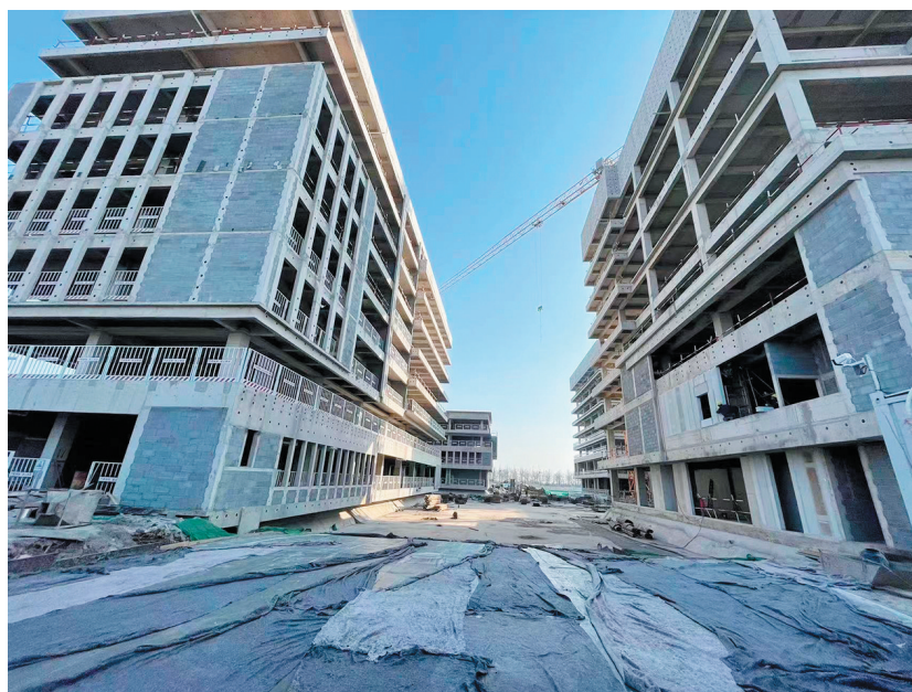
■正在加紧建设中的空港综保展示交易中心。 马英歌 摄
