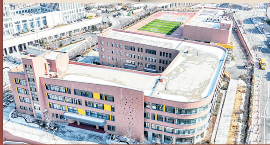
■航拍富春江路小学教育集团结路校区。
