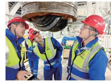
在胶州湾第二隧道项目施工现场，工作人员检查“海天号”盾构机刀具换刀情况。
