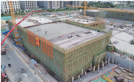
■城阳区污水处理厂四期MBR膜池顶板浇筑现场。
