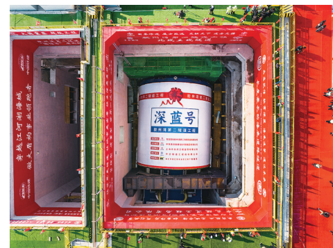
■1月26日上午，胶州湾第二隧道北线“深蓝号”超大直径泥水盾构机顺利始发。 国信集团 供图
