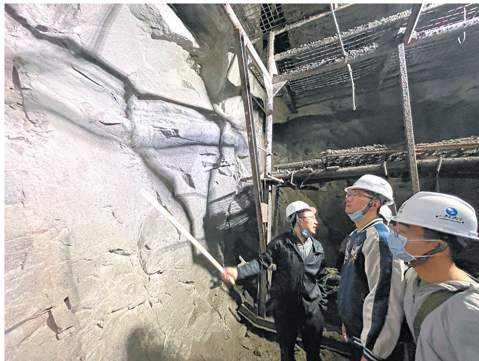
山东科技大学科研团队在青岛地铁施工现场勘察。
