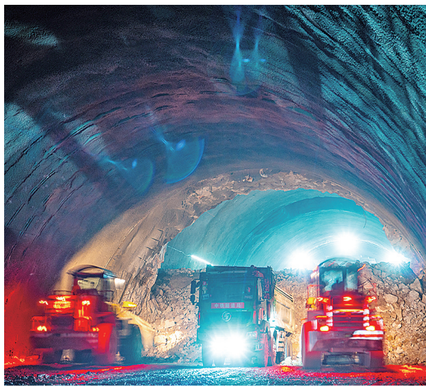
■2023年12月26日，胶州湾第二隧道项目黄岛海域段南线与陆域段隧道顺利贯通。
