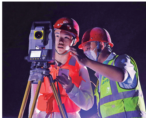
■技术人员正在开展隧道监控量测作业。
