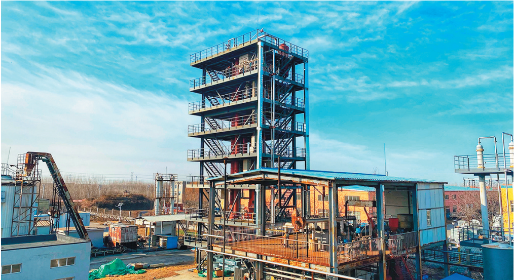
■青岛能源所(山东能源研究院)在平度建设的年处理生物质量1000吨的中试实验装置。
