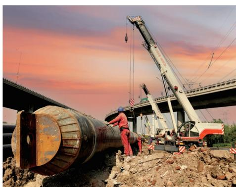
■市区主干道路敷DN1200供水管道施工现场。
