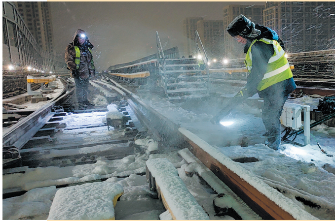
■青岛地铁信号正线检修工深夜对正线道岔检修、除雪。
