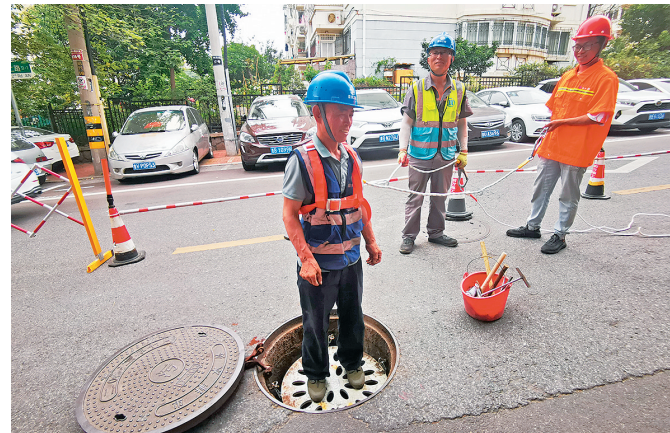
■排水窰井防坠隔板安装完毕进行承重测试。
