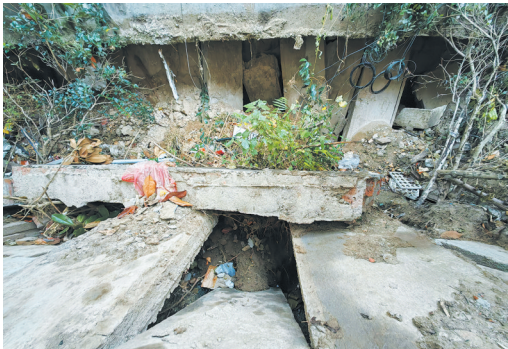
■暗渠顶部的预制板塌陷。
