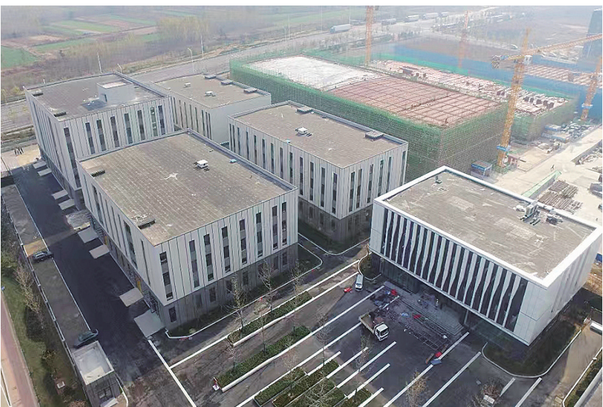
■芯屏产业园一期启用。
