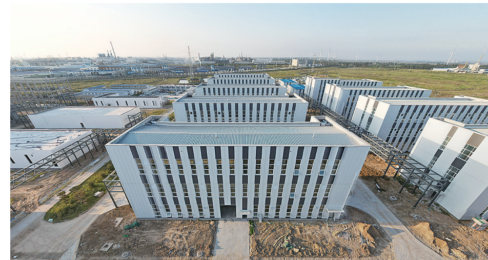
■建设中的平度新河高端化工共享工厂项目。
