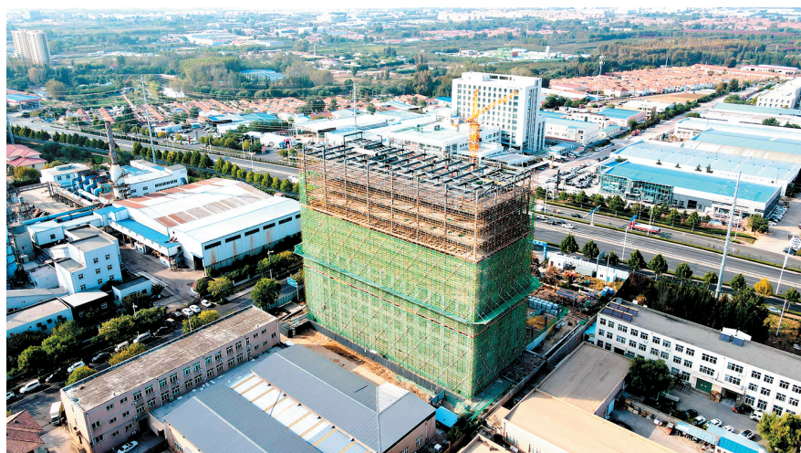
青岛智能汽车配件产业园项目主体封顶。
