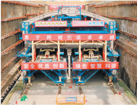
■青岛地铁预制装配建造技术。
