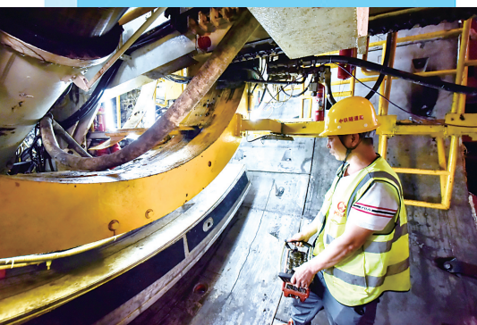
■9月2日,青岛地铁三期工程首台双模盾构机“鲲鹏号”从山东省在建最大体量车站——闫家山站始发。图为盾构机管片拼装现场。
