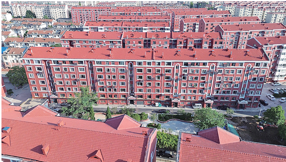
改造后焕然一新的水寨花园小区。
