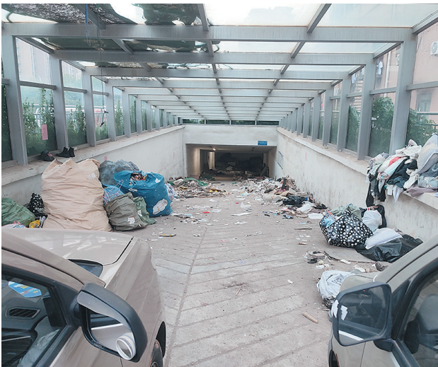
大,街道办计划出售剩余房源筹措资金;2021年的答复是:小区地下车库没有划线,且通风、照明设备损坏,尚不具备启用条件。街道办正牵头招标,待招标完成后启动维修;2022年答复:地下车库因消防验收久未通过,不具备启用条件,小区高层消防整改项目已列入区2022年度固定资产投资计划,由政府财政和各经合社共同出资维修,施工单位已于当年9月进驻维修,计划2022年年底完成所有修缮;近期,街道办表示:消防设施维护工作已接近尾声,待验收完后将逐步
