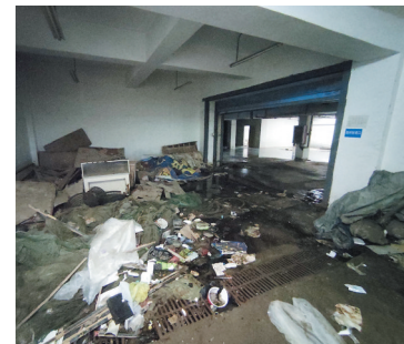
▲ 地下车库内有积水和垃圾。
