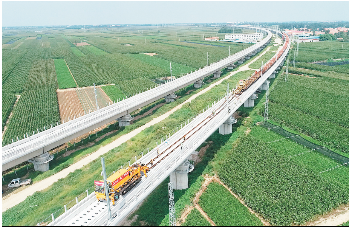
正在铺设轨道的潍烟高铁。
