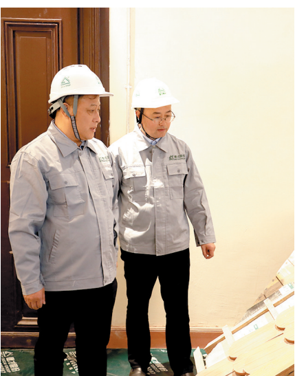
■叶德才(左)到市南区历史文化街区保护更新项目现场调度项目进展情况。
