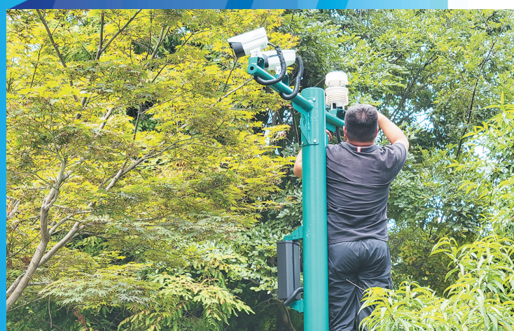
■太平山中央公园内,工作人员在安装调试摄像头等设备。
