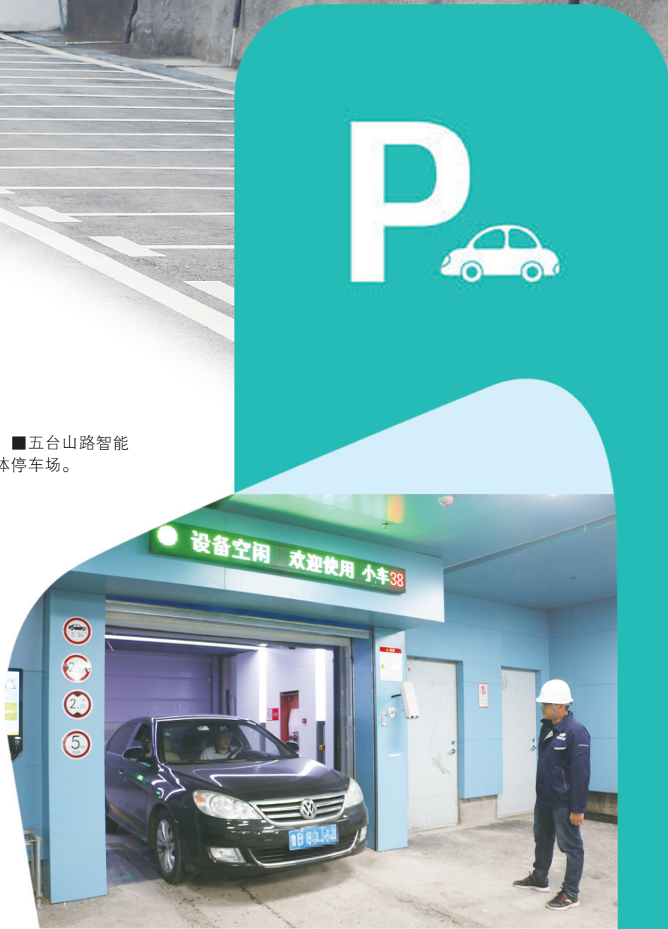
■工作人员正在测试中山商城人防停车场内的机械车位。
