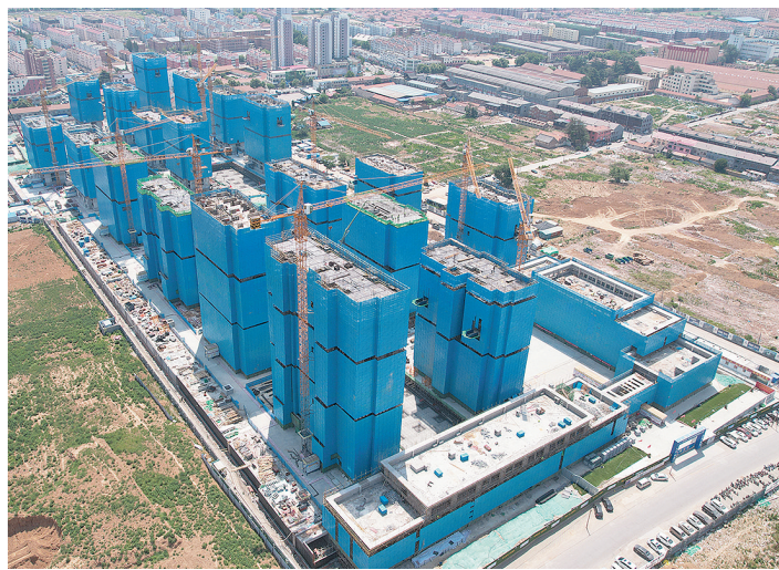
王台旧村改造项目二期首批住宅楼顺利实现主体封顶。
