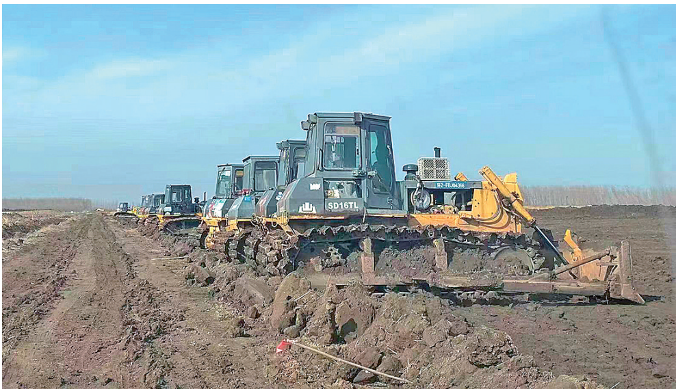
■官路水库库区内工人开着推土机清表作业。
