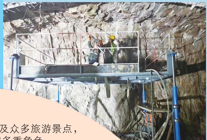
■地铁2号线二期的工人们正在开展支护结构施工。
