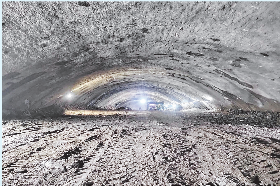
■地铁2号线二期龙川路站主体拱部顺利贯通。
