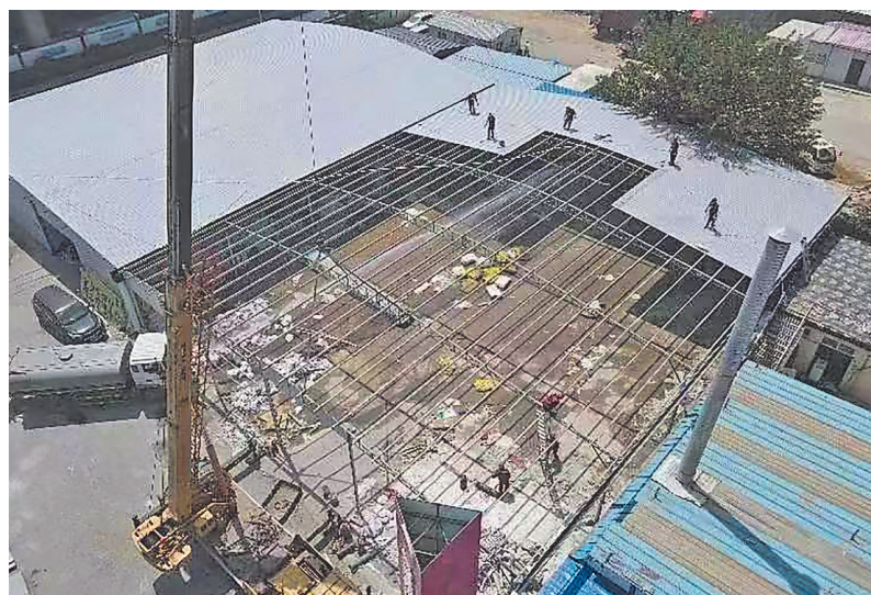
■洛阳路二号钢结构违法建筑拆除中。
