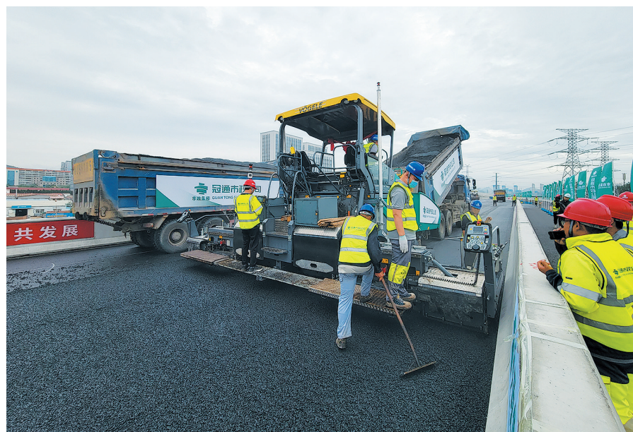
■工作人员正在使用3D智能摊铺设备铺设路面。
