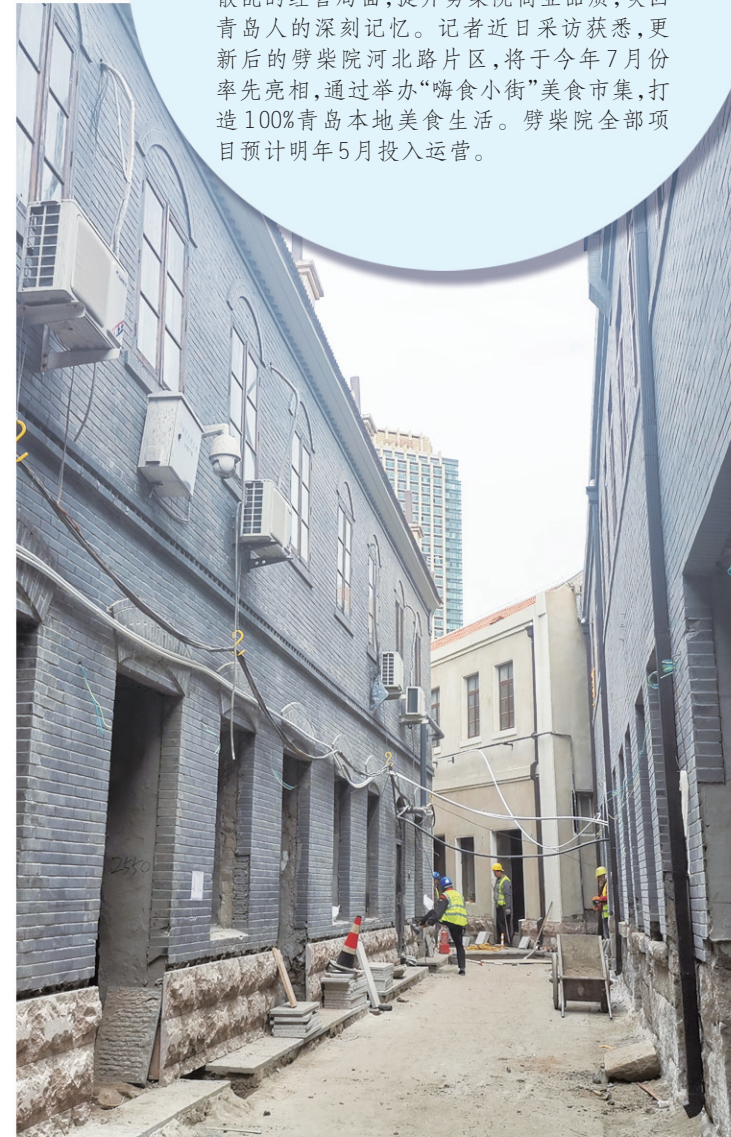
■正在更新改造的劈柴院。
