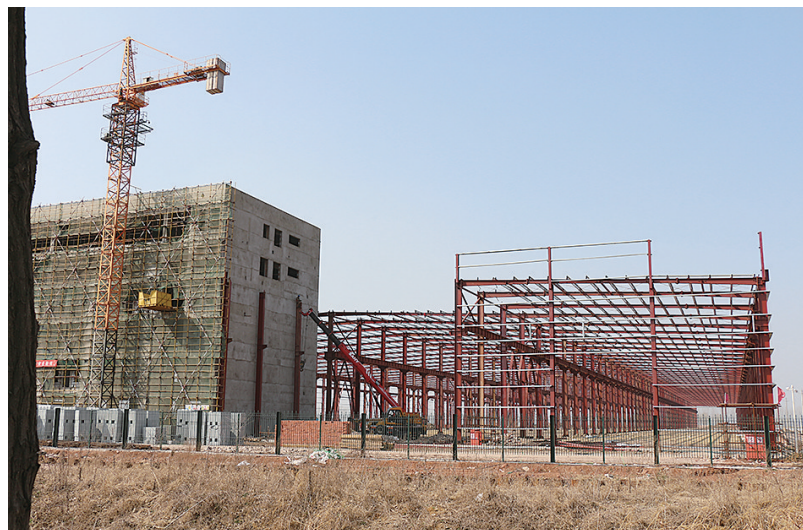
青岛文锦轨道交通产业园项目建设现场。
