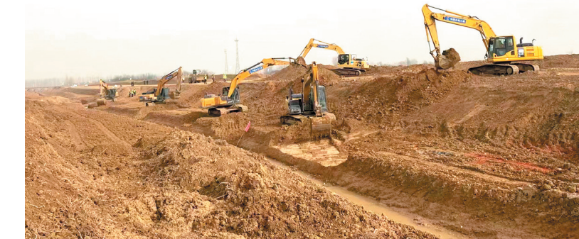
■官路水库建设现场正在开展河道改道和围坝清基工作。
