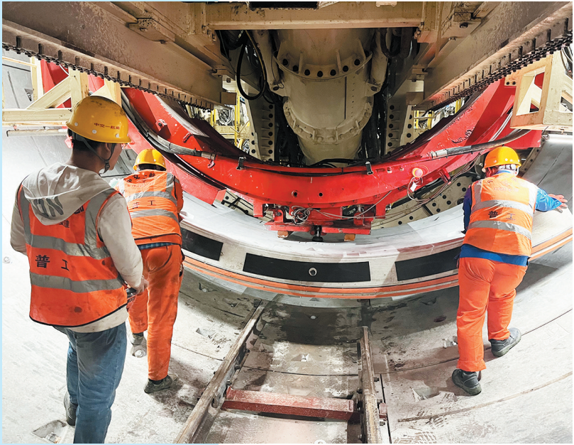
■8号线支线盾构机掘进现场,工人们正在拼装管片。
