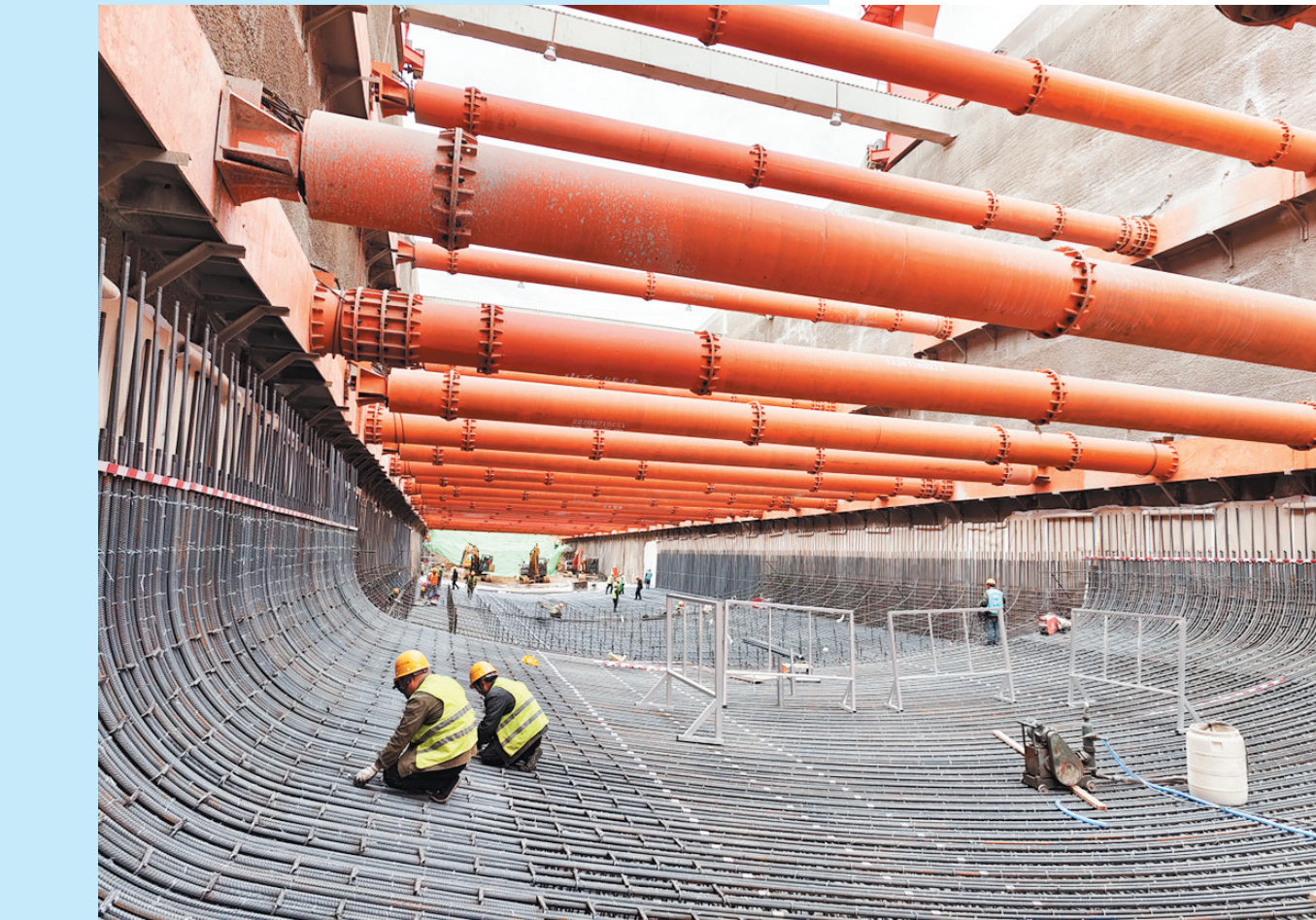
■2号线合川路站内,工人正在加紧施工。
