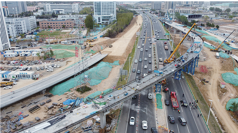
■跨海大桥高架路二期工程跨青银高速段钢箱梁顺利合龙。
