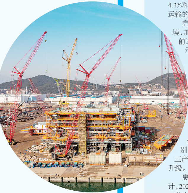
■渤海油田渤中19-6凝析气田I期开发项目CEPA(中心处理平台)组块在海油工程青岛建造场地完成封顶。
