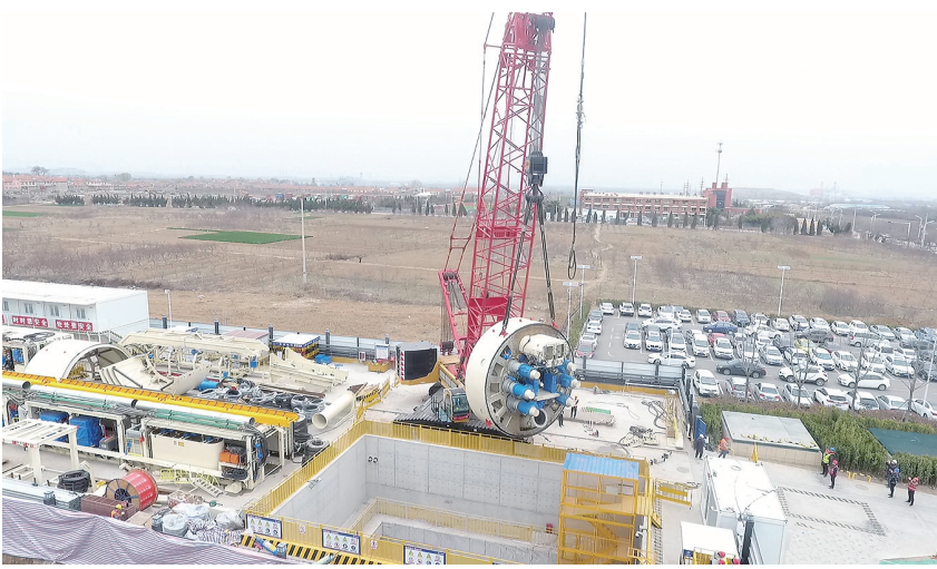
■地铁8号线支线大涧站盾构井施工现场，青岛地铁三期线路首台盾构机顺利吊装下井。
