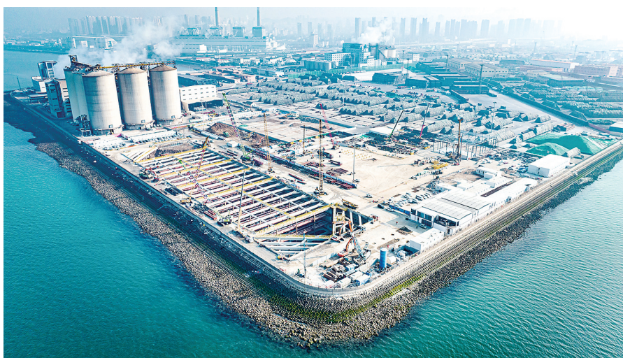
■胶州湾第二隧道工程青岛端建设现场。
