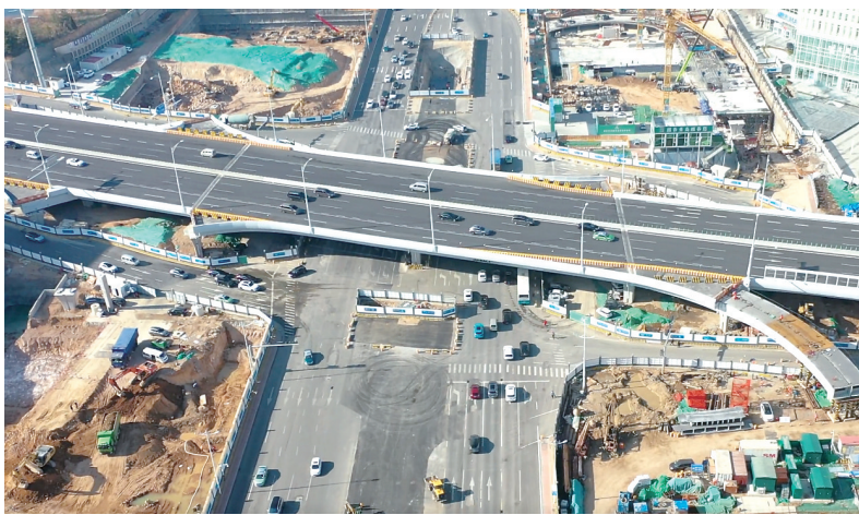
■海尔路—银川路立交工程正在推进四个象限匝道桥和地下空间建设。
