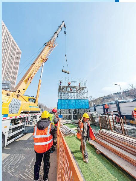
■重庆路快速路工程施工现场，井然有序。王冰洁 摄
