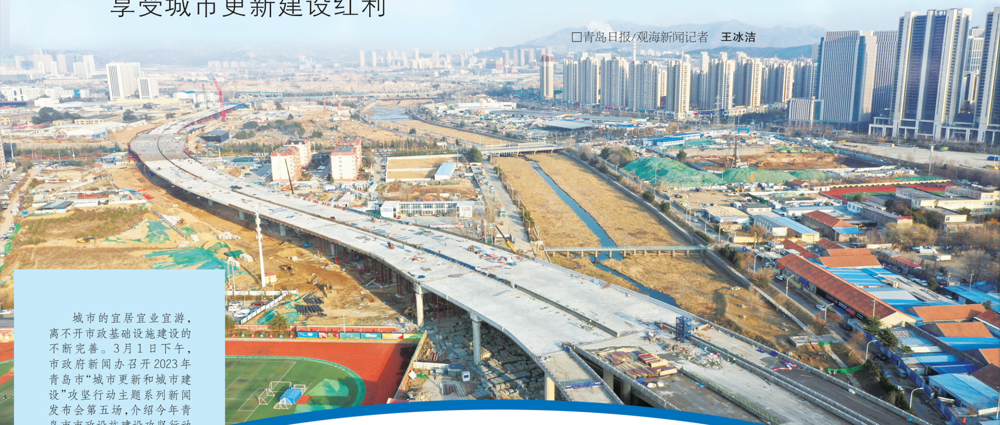
■跨海大桥高架路二期工程建设现场。
