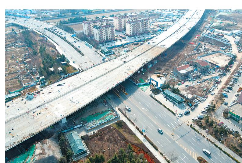
24日下午，在深圳路节点桥处看到，桥面上方工人们正在绑扎钢筋，而桥面下方的临时支撑体系正在拆除，目前贝雷梁已经拆除完成，后续还将把钢管柱及临时混凝土基础全
