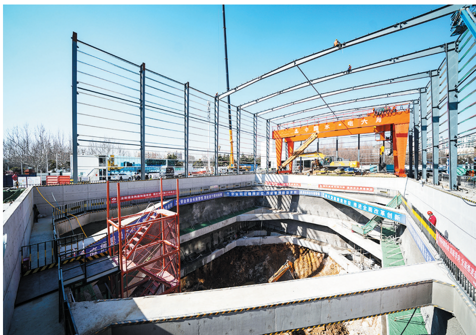
■15号线下富区间施工现场。
